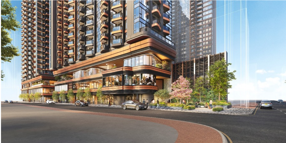
圖二：「One Victoria Cove 首岸」基座商場擁有近 12 萬平方呎商業樓面面積，由希慎興業有限公司統籌及營運。
